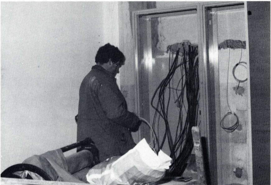
Der Elektriker arbeitet am Hauptverteiler im Erdgeschoß (Anfang April 1989)
