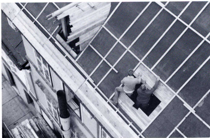
Ausbau der Dachgauben auf der Seite zum Oberen Stadtplatz (Mitte November 1987)
