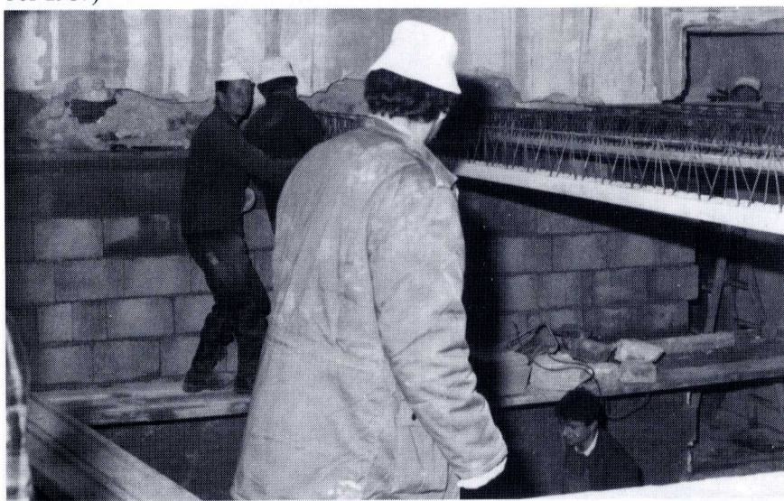
Im Hof entsteht oberhalb der Schmiede ein neuer Raum. Das alte Dach und die Dachüberdachung sind abgetragen – eine neue Fixdecke wird eingezogen (Anfang Dezember 1988)
