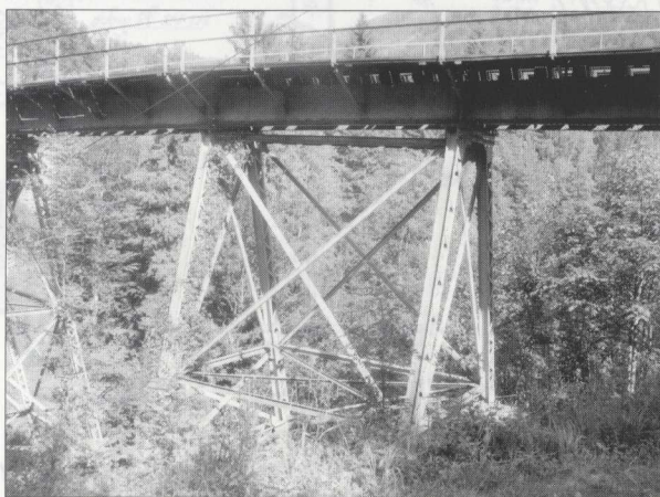
Ybbstalbahn, Wetterbachbrücke, gegliederte Stützen (Archiv RH)
