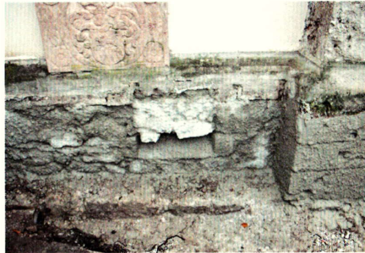
Vermaurtes Fenster im Sockelbereich der Kirche neben dem Haupteingang, der heute unter der Erde liegt. Man beachte auch die schön behauenen Quader des Strebepfeilers, die heute nicht mehr sichtbar sind. Alles Beweise für ein tieferes Niveau rund um die Kirche.
